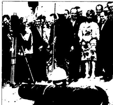
Comienzo de las obras del abastecimiento, en 2001.
