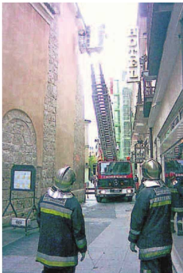
Los bomberos retiran cascos de un edificio. ■ J. SANZ
