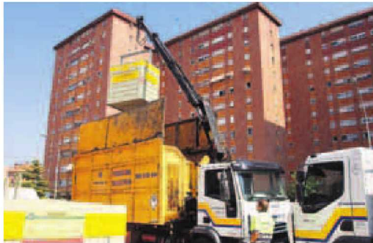
Instalación de uno de los contenedores en Torrelago. / P. C.
