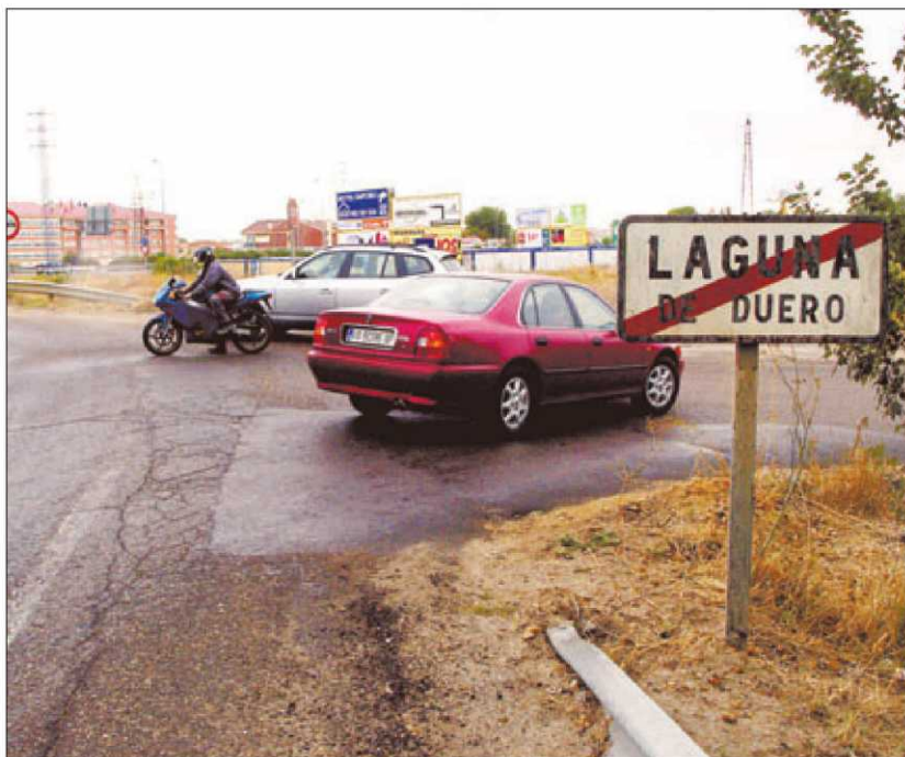
Estado actual del cruce entre el camino del Portillejo y el acceso a la N-601, junto a los terrenos del Sector 1. / O. ÁLVAREZ
