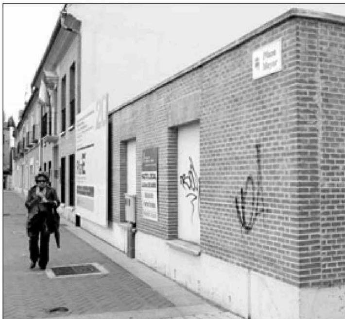
Lugar en el que se construirá el nuevo edificio administrativo. / Ó. ÁLVAREZ
