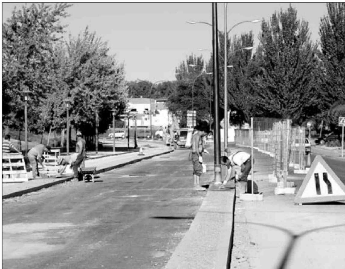
Obras de urbanización y pavimentación en una calle de Laguna de Duero. / ÓSCAR ÁLVAREZ
