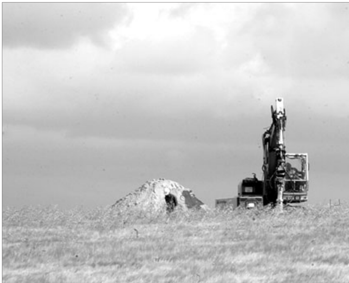
Una máquina realiza trabajos para la instalación de la línea de alta tensión en La Seca. //JONATHAN TAJES
