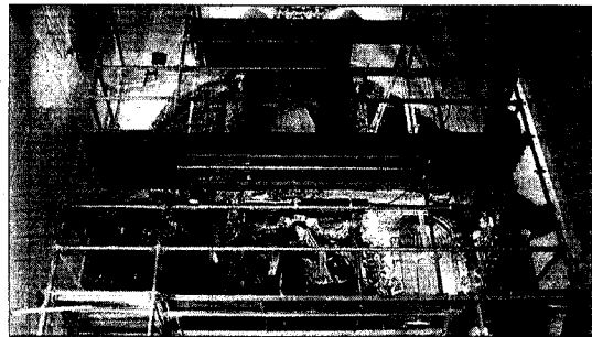
Trabajos de restauración en la iglesia de Castromonte. / M.C.M.
